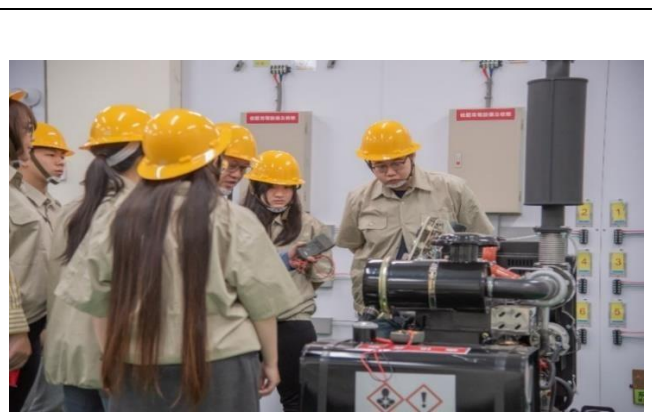
機電設備實習工廠
